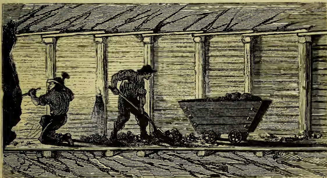
Fig. 35. — Vue longitudinale d'une galerie boisée.
